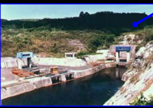
T. Agung Tunnel (91)
